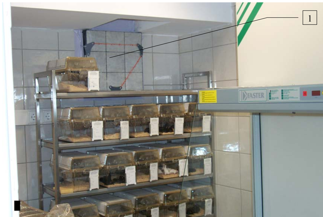
Φ1: Κλωβοί πειραματόζωων εντός του animal facility. Διακρίνεται στο πάνω μέρος το στόμιο εξαγωγής του αέρα με ειδικό φίλτρο κατακράτησης οσμών [1] .
