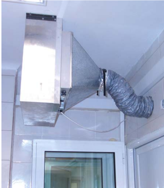
Φ4α: Απόλυτο φίλτρο HEPA πάνω από την πόρτα του animal facility για την επεξεργασία του εισερχόμενου αέρα.
