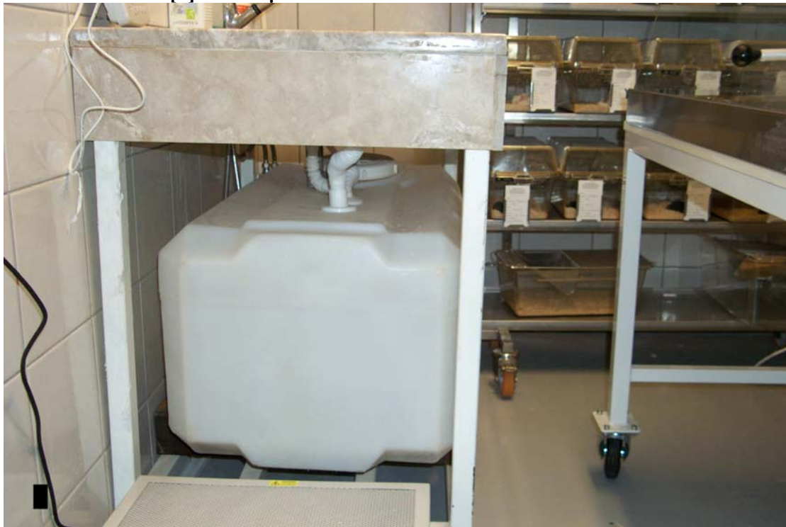
Φ3: Δεξαμενή συλλογής και απενεργοποίησης υγρών λυμάτων [4] (εντός του animal facility)
