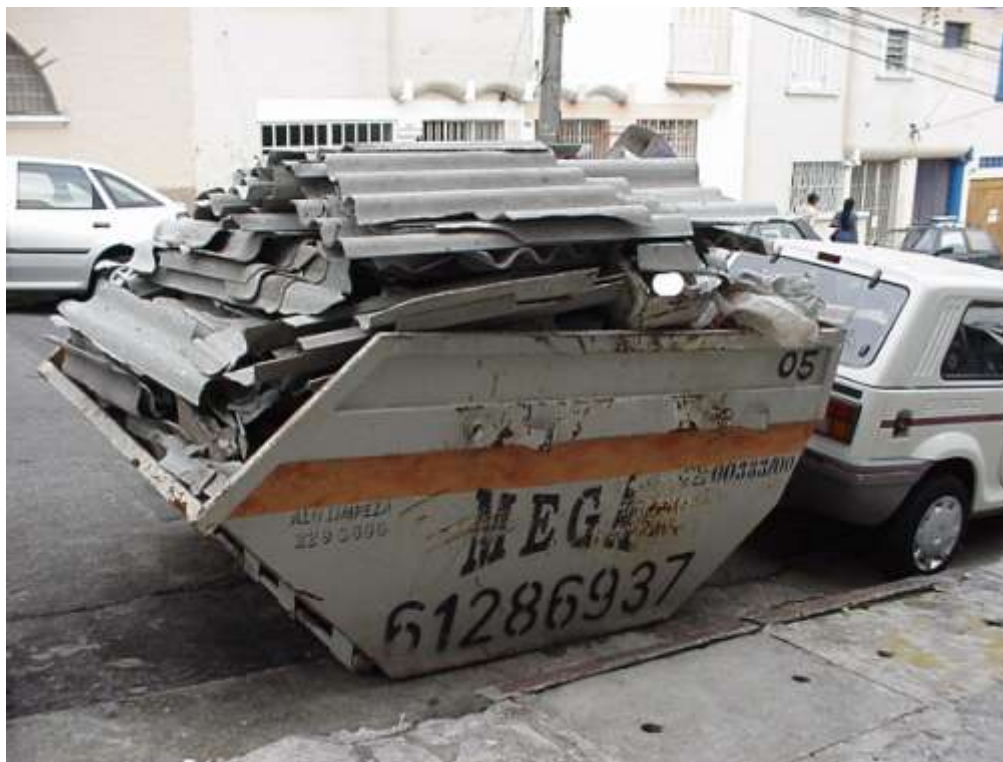
Foto 10 – Pela Resolução 348/2004 do CONAMA, este resíduo deve ser destinado em aterro para lixo perigoso (classe I).
