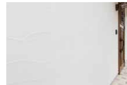
外壁、室内すべてスペイン漆喰塗り壁で仕上げます
