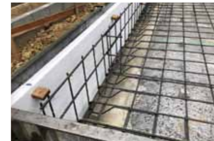
基礎には外断熱(防蟻ハウ酸入り)60ミリの厚さの外断熱を採用
