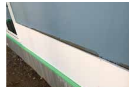
外断熱材EPSで外断熱を採用
