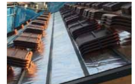
遮熱タープホイルは放射熱を97%反射します
