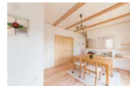
漆喰塗り壁はスペイン漆喰を使用
