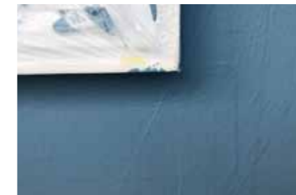
気密性能がアップする透湿性能のある防水塗料ウェザーシールを採用
