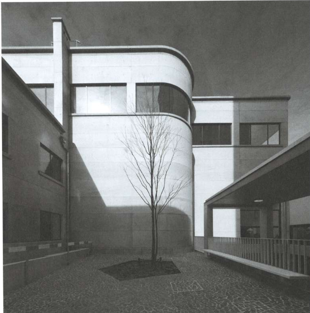
→ Nieuwe toegang met patio.
