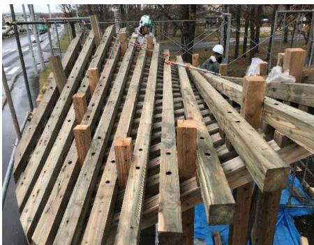
HP シェル格子梁建方
