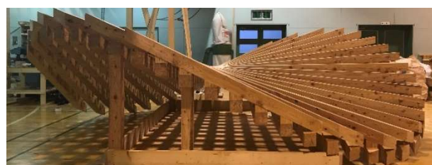
屋根格子梁の仮組
