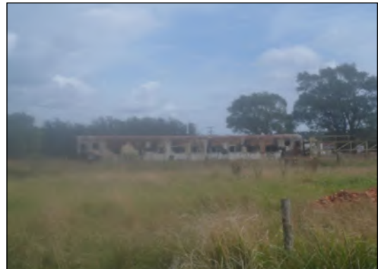
Foto 2. Vagón abandonado en Estación Chapadmalal
