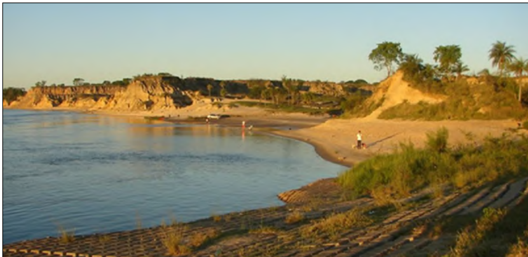
Figura 3. Obras de defensa costera en Balneario de Empedrado
