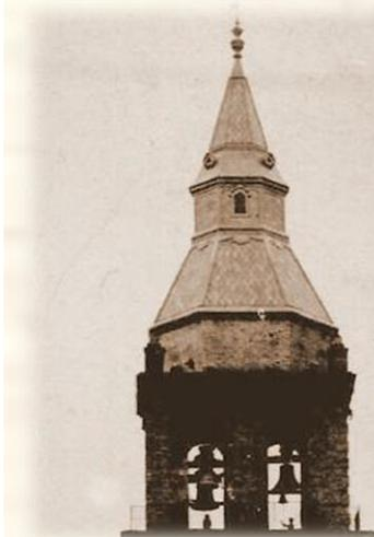
Rematando la construcción, el chapitel de la torre se asienta sobre una estructura poligonal de ladrillo. Las chapas de zinc recubren una estructura de madera realizada tras la guerra civil por Juan Rueda Mercado, ya que el antiguo chapitel fue desmontado para instalar un nido de ametralladoras durante la contienda. Ignoramos si el chapitel que muestra la fotografía es el proyectado en 1872 por el arquitecto D. Lesme Hurtado.
