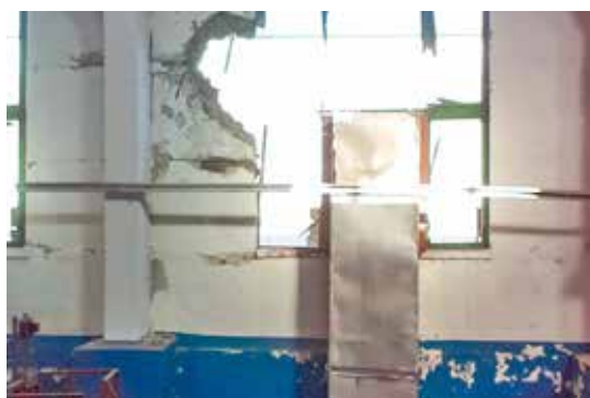
Будівля насосної станції (вид зсередини)
