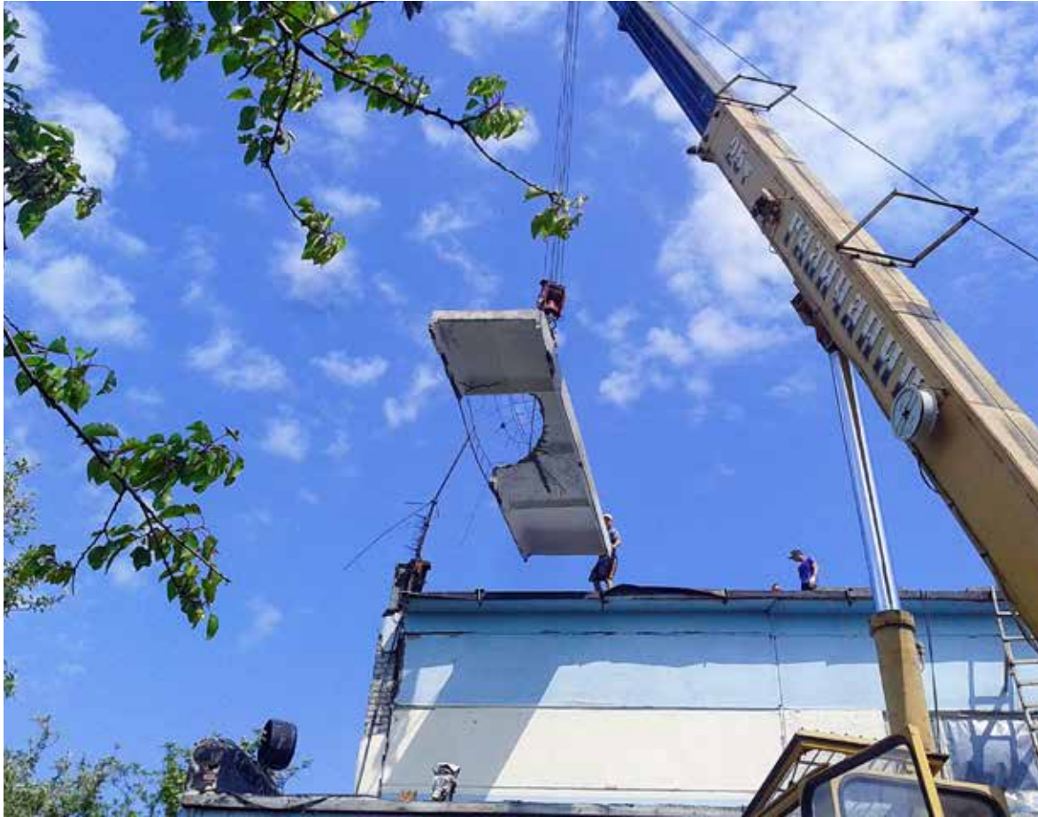
Відновлення роботи станції
