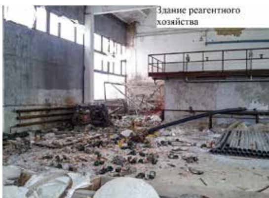
Будівля реагентного господарства
