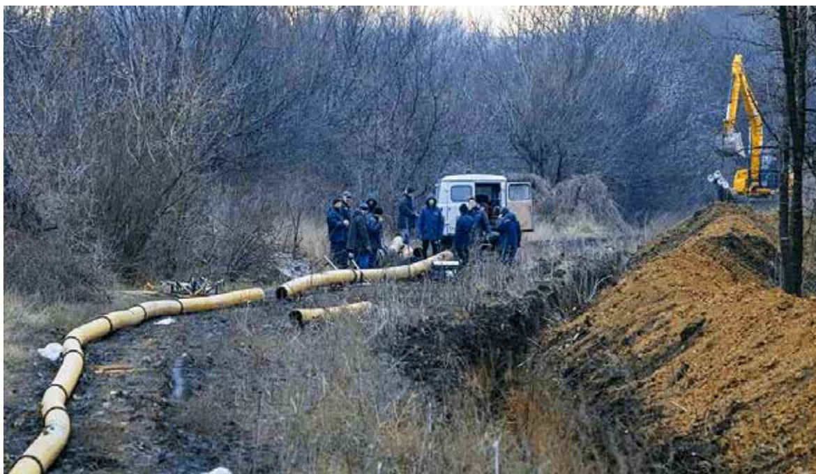
Будівництво підвідного газопроводу до м. Авдіївка 22
