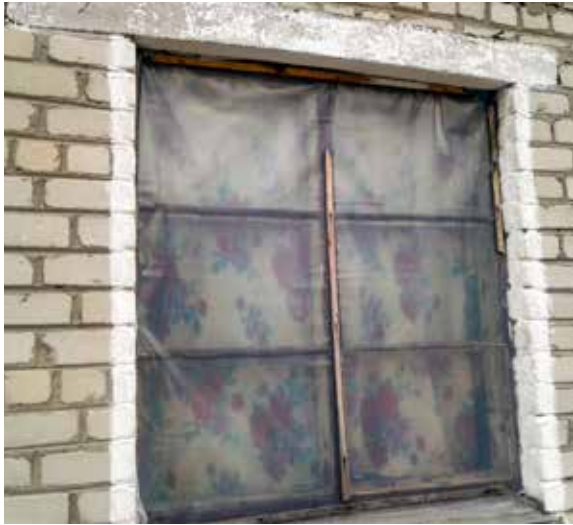
Закладені цеглою та плівкою вікна після обстрілів
