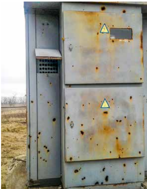
Пошкоджений трансформатор 52
