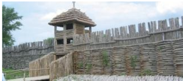
Murallas reconstruidas del poblado de Biskupin (Pomerania, en Polonia). La construcción aprovecha las características del territorio, suelos profundos que permiten la excavación de fosos y abundancia de troncos rectilíneos. Este asentamiento estuvo ocupado desde el siglo VIII hasta el II a. C. Fotografía de J. Santacana.
