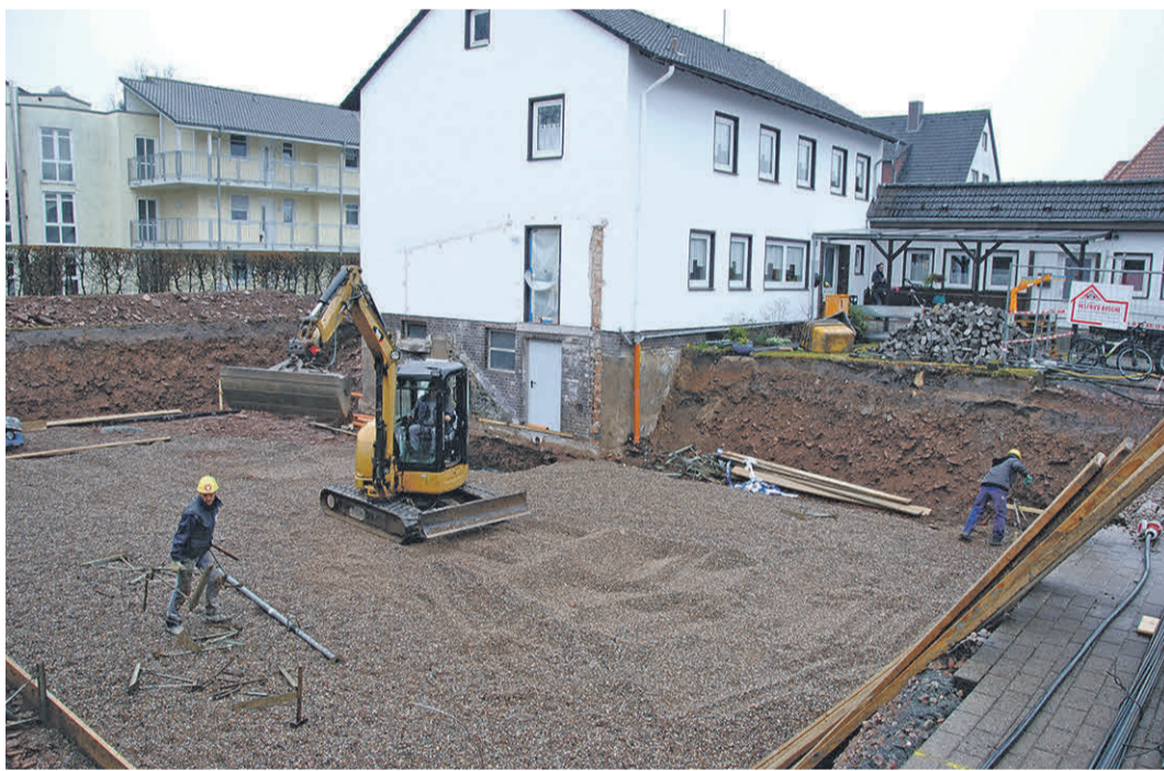
Die Baugrube ist bereits ausgehoben. Hier entsteht das Mehrfamilienhaus.
