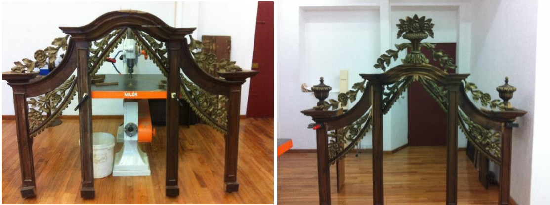
Figura 3 – Consolidação e recomposição dos elementos de talha que decoram a parte superior da caixa do órgão.
