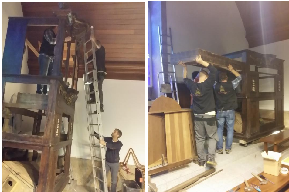
Figura 1 – Desmontagem do órgão, anteriormente implantado sobre o coro alto da Igreja Matriz de Ribeirão.
