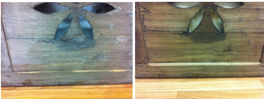
Figura 6 – Exemplo de reconstrução de partes da caixa do órgão seriamente comprometidas, sempre com madeira da mesma qualidade.
