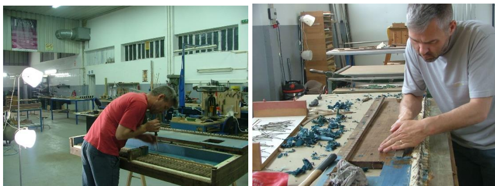
Figura 16 – Restauro do someiro; remoção das antigas peles que o forravam, já secas e que, portanto, comprometiam seriamente a desejável estanqueidade do mesmo.
