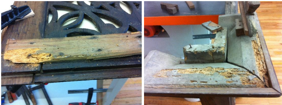
Figura 4 – Comprometimento de determinadas partes da caixa do órgão devido à ação de insetos xilófagos.
