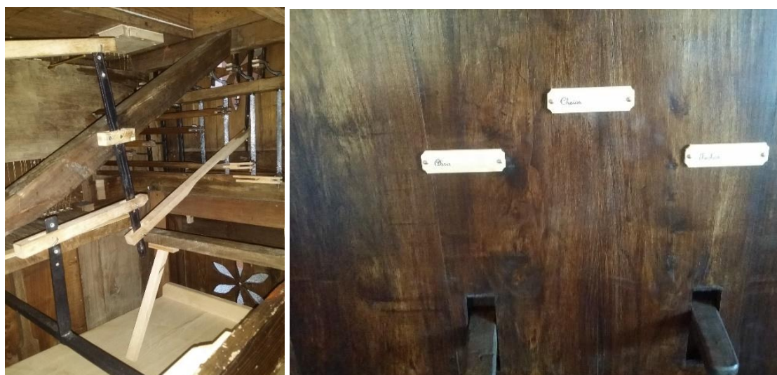
Figura 25 – Mecânica correspondente aos anuladores de cheios após o restauro.
