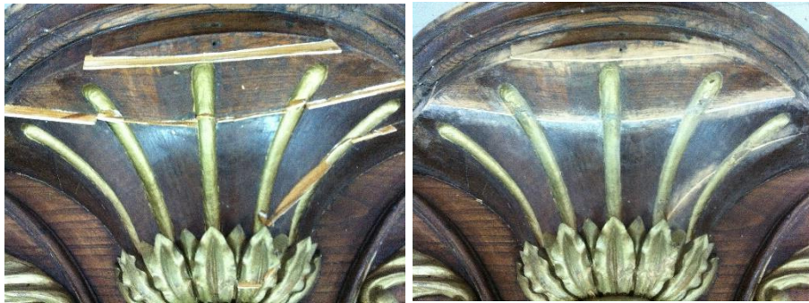
Figura 8 – Exemplo de reconstrução de partes da caixa do órgão seriamente comprometidas, sempre com madeira da mesma qualidade.
