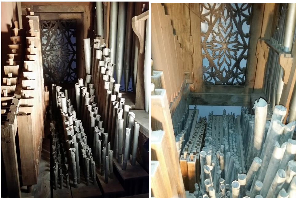
Figura 35 – Tubaria interior do instrumento antes do restauro.
