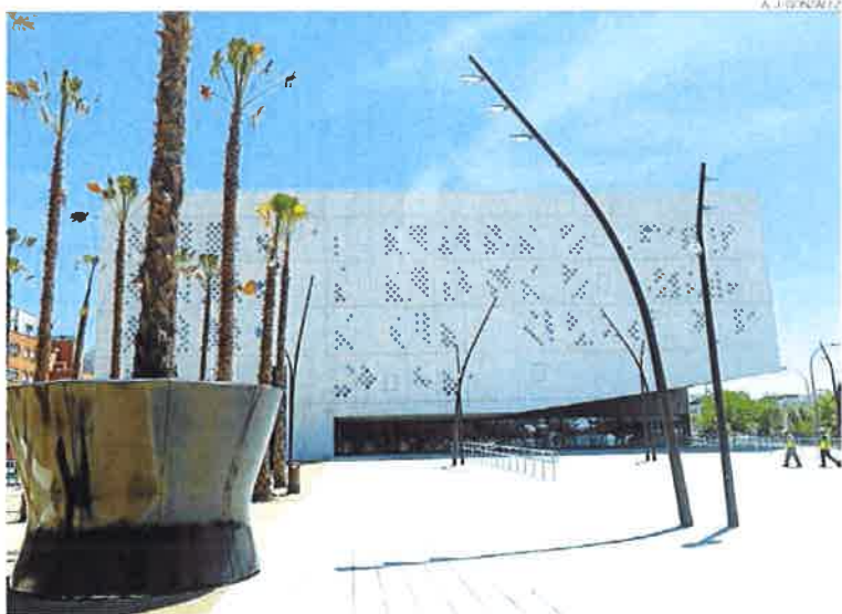
►► Exterior del nuevo edificio que albergará la Ciudad de la Justicia, en la zona de Arroyo del Moro.
