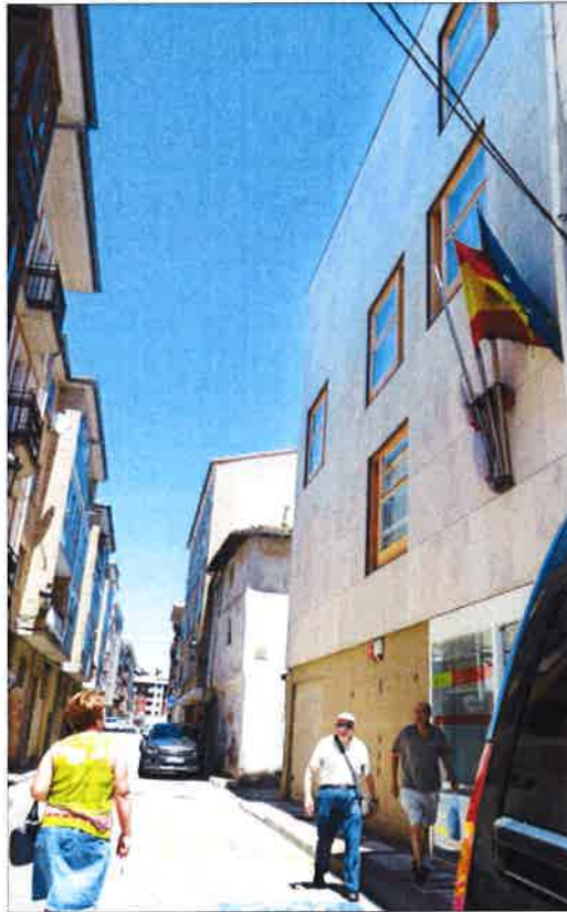
Fachada del Juzgado de Primera Instancia e Instrucción de Briviesca. / M.J.F.
