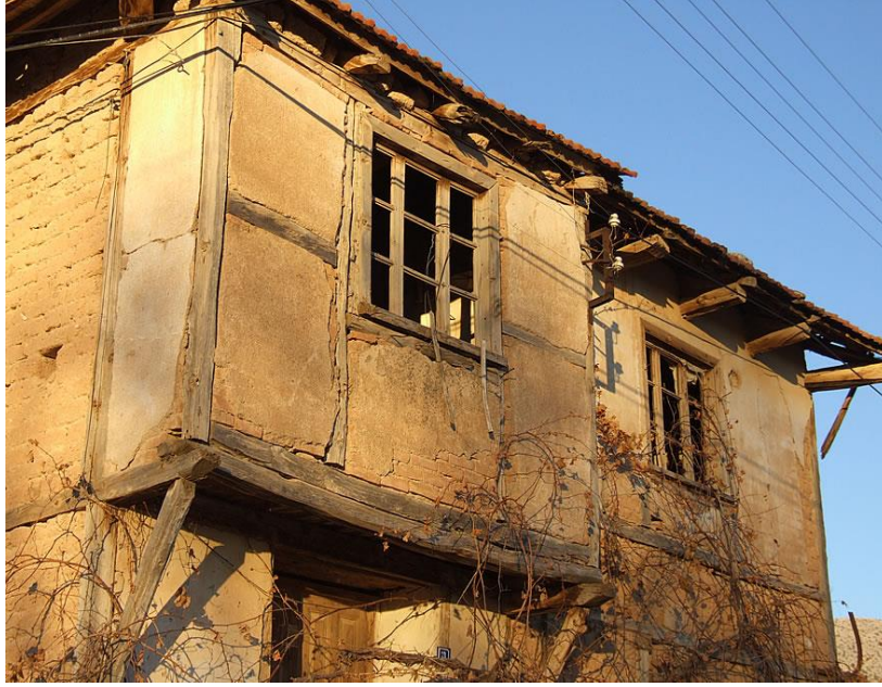
Resim 4. Kerpiç kullanılarak üretilmiş Kilis evi (Örnek4)
