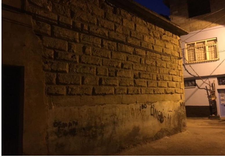
Resim 2. Kireç harcı kullanılarak üretilmiş Kilis evi (Örnek 2)
