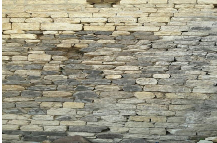
Resim 3. Horasan harcıyla kullanılarak üretilmiş Kilis evi (Örnek 3)
