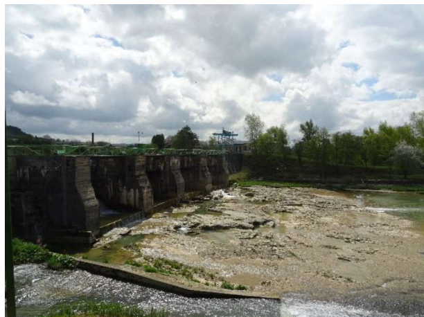
Barrage hydro-électrique de Blye-Charézier Source : EVEN Conseil
