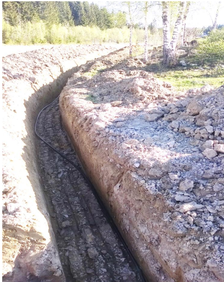
Ny vannledning Vinterstad - Skalby
