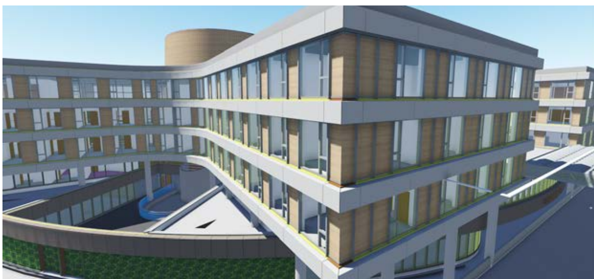
Centre hospitalier Chirec, Bruxelles
