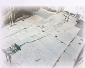
球場工程進行中
