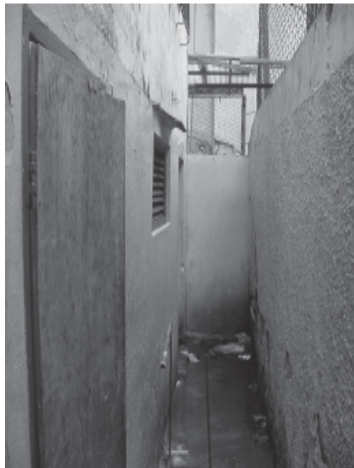
PASILLO QUE CONDUCE A LOS SANITARIOS DE HOMBRES EN EL BAÑO DE LA CAFETERÍA DEL PÍO PÍO. LA PUERTA ENTREABIERTA PERTENECE A LOS SANITARIOS DE LAS MUJERES.
