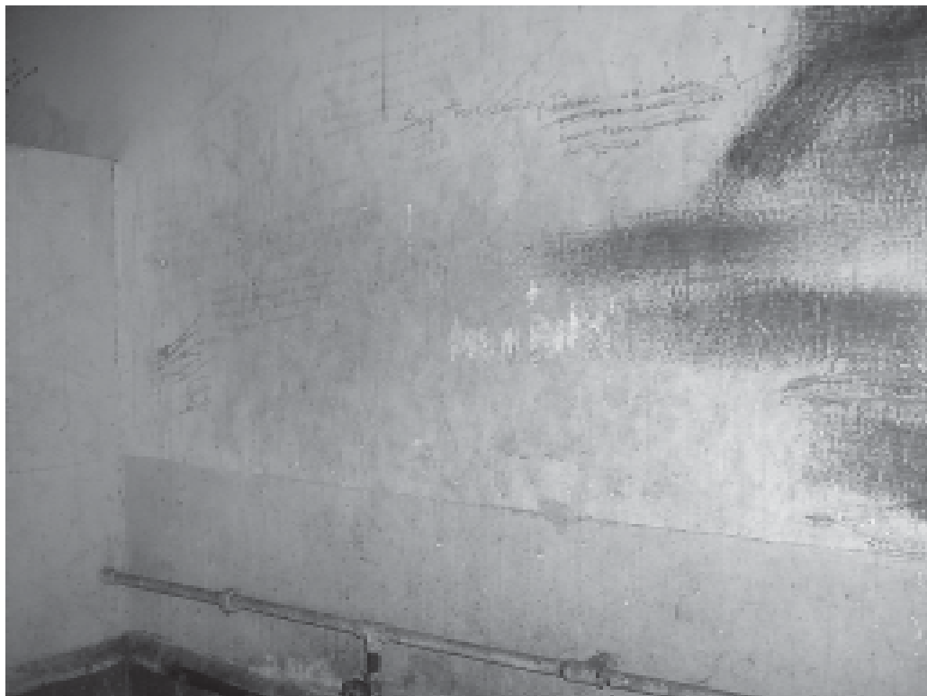
VISTA INTERIOR DE LOS SANITARIOS PARA HOMBRES EN EL BAÑO DEL PÍO PÍO.
