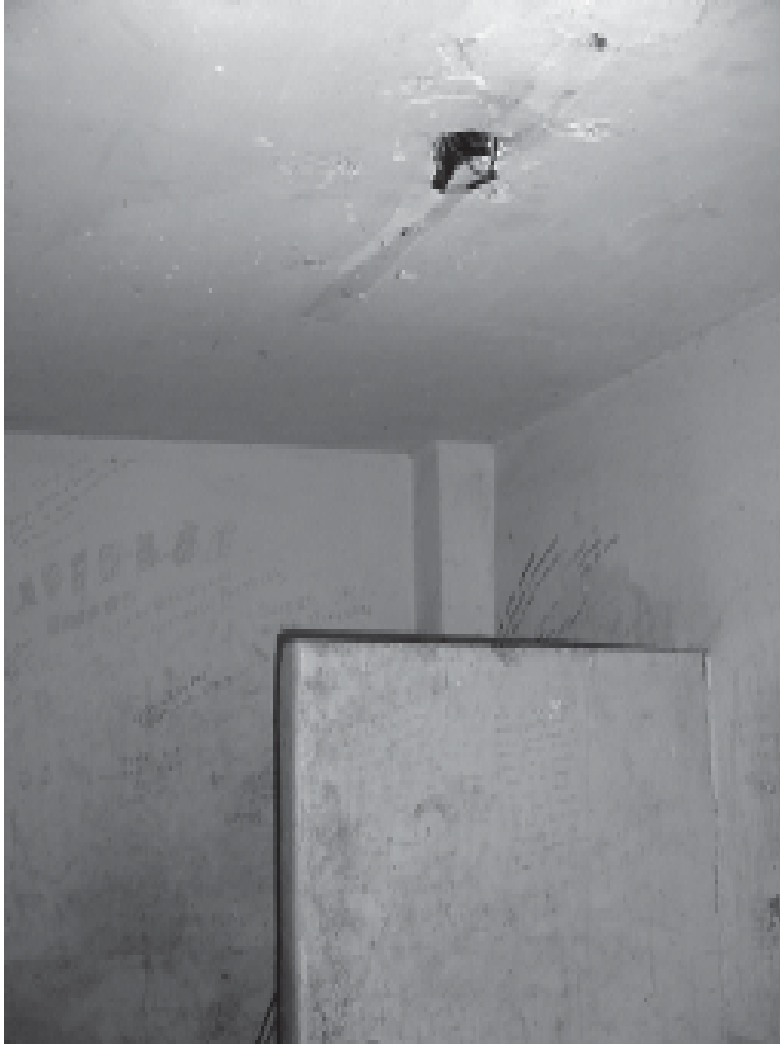
VISTA INTERIOR DE LOS SANITARIOS PARA HOMBRES EN EL BAÑO DEL PÍO PÍO.
