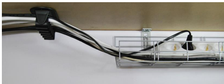
Johtopidike Holdirexin ja johtokori Caban yhteiskäyttö
