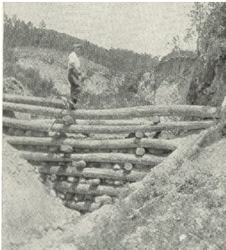
Fotografia 1 - Sebes (Vale do Olheiro); Fotografia 2 - Barragem de madeira e calhau rolado, em construção (Ribeiro do Vale do Olheiro); In Noções de Hidráulica Florestal , Ruy Mayer, Edição da Direcção Geral de Serviços Florestais e Aquícolas, 1941.
