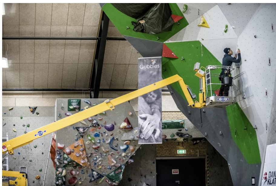
Bomlift i brug ved Lead DM i Sønderborg 2017
