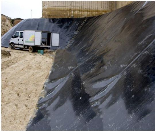
Fig. 5 Impermeabilizzazione pareti – Lotto 4. Fig. 6 Bacino di fondo allestito per lo scarico dei rifiuti – Lotto 3.
