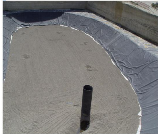
Fig. 5 Impermeabilizzazione pareti – Lotto 4. Fig. 6 Bacino di fondo allestito per lo scarico dei rifiuti – Lotto 3.
