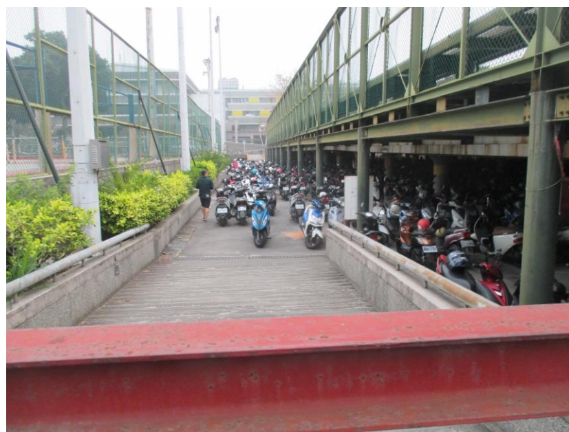
2019.4.3：機車停車場之通道也停車堵道了
