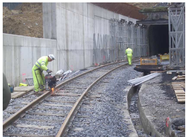
Vista de los trabajos de reposición de las vías.
