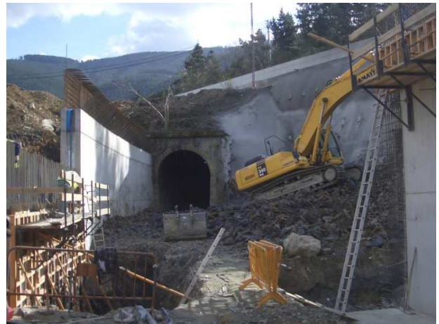
Vista de la excavación y contención de la boca del túnel
