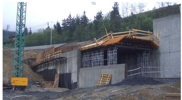
Vista de la cimbra de la losa superior con los hastiales ya construidos.
