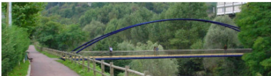
Fotomontaje de la pasarela metálica en su ubicación definitiva
