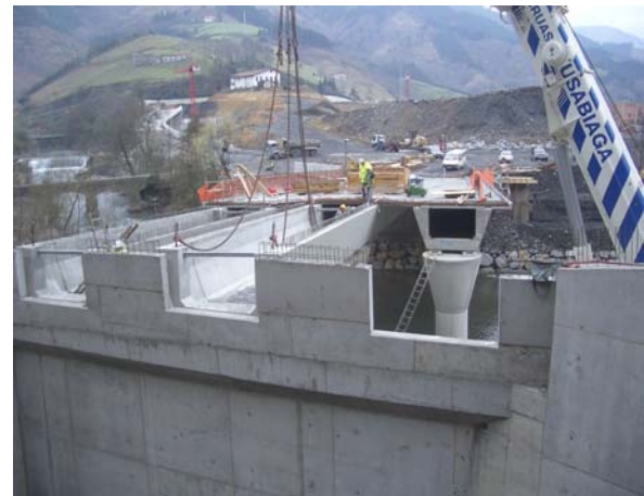
Vista del montaje de las vigas
