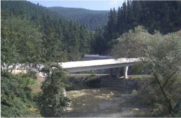
Vista del puente terminado
