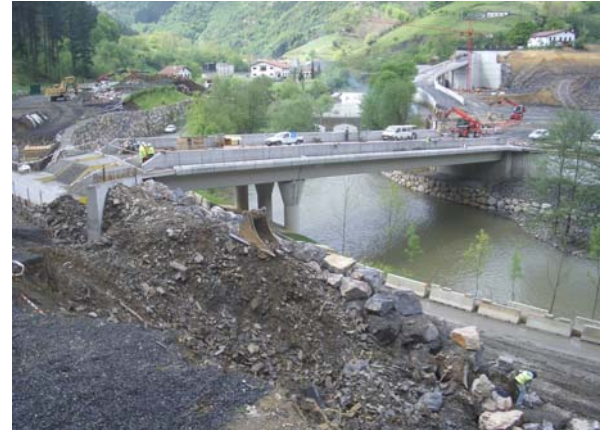
Vista del puente en obras
