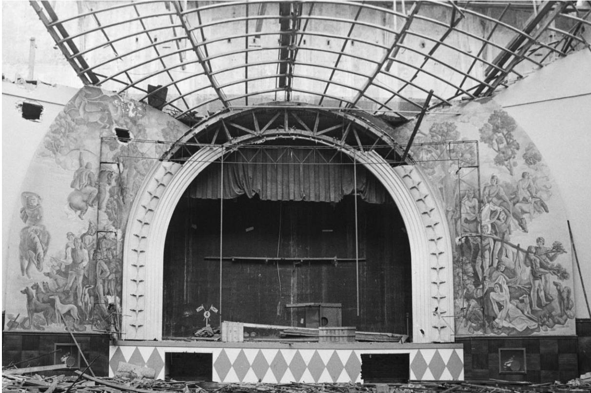
Imagen del Cine Diana de Logroño durante su demolición. Fotografía de Teresa Rodríguez
