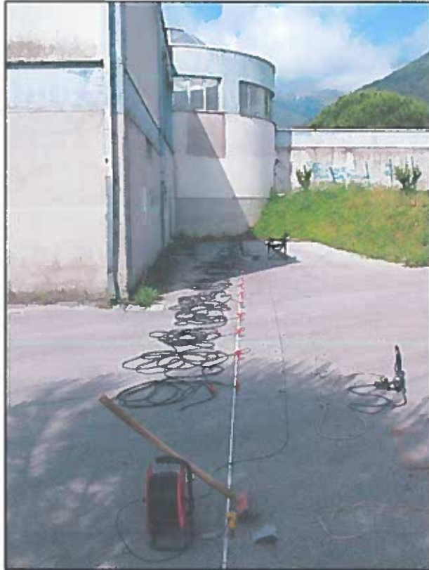
Foto 1 – Esecuzione del profilo MASW 1
