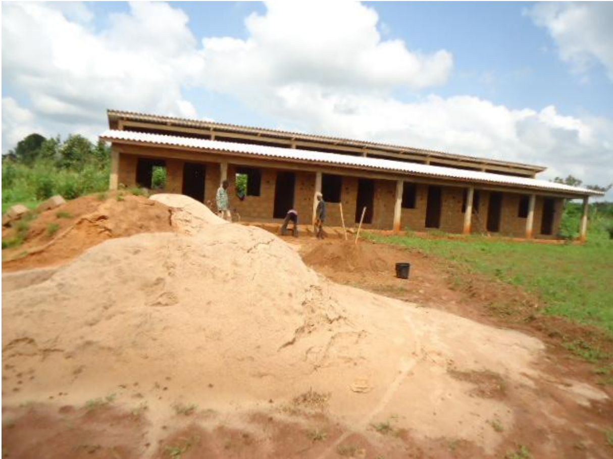
Bouw dortoir 1 , situatie november 2014
