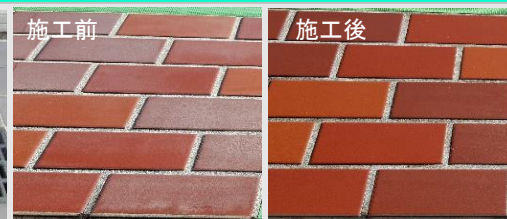
レンガ調タイルの復元 コートウェット
