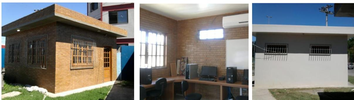
**Figuras 1 e 2.** Vistas externa e interna do módulo em solo cimento. **Figura 3.** Módulo convencional. Fotos março de 2012.
