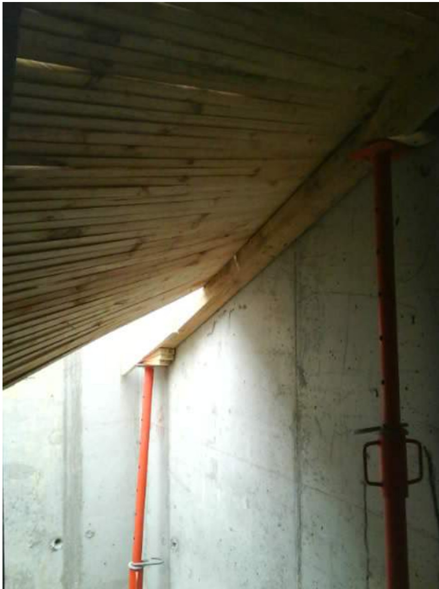
Apuntalamiento vertical al piso con puntales telescópicos metálicos. El acuñado se coloca entre el puntal y la costilla guía sobre la cual se clavan las “tablillas” en forma de cuña del piso de losa.
