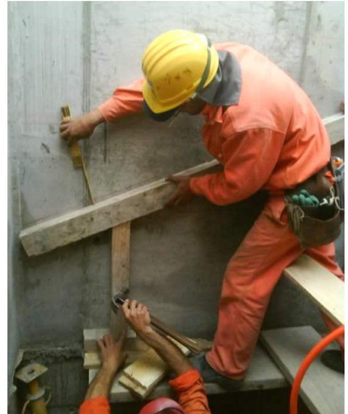
Se marca desde el replanteo dibujado sobre la pantalla de H.A, la base del tablero de la losa de la escalera y el encuentro de huella y contrahuella.
