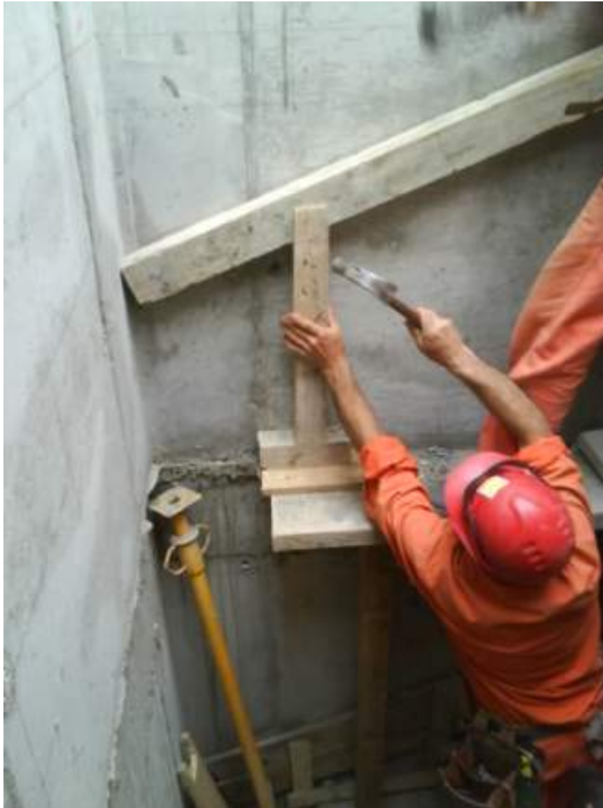
Colocación de costilla de apoyo para el fondo de losa de una escalera sobre una pantalla de H.A.
