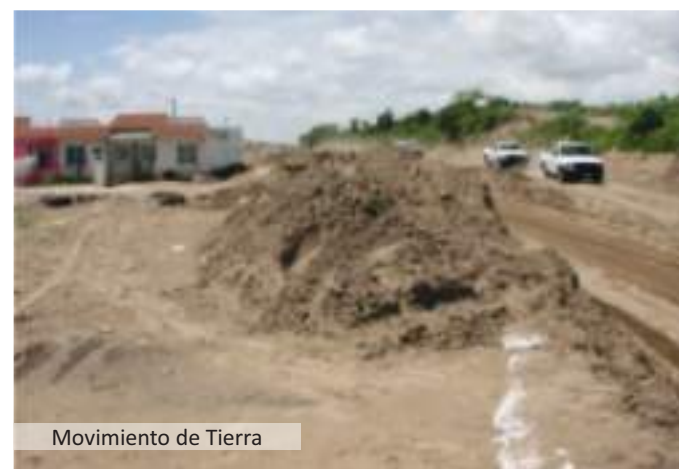
Desmonte: Consiste en Rebajar el Terreno por Extracción
