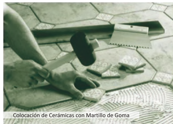
Mortero Aplicado Directamente Sobre Contrapiso
