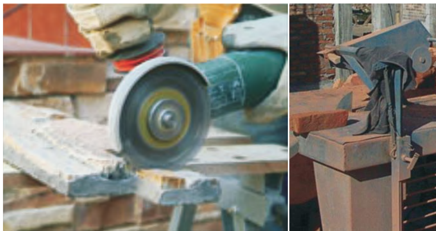
Corte de piezas cerámicas, pétreos con herramientas eléctricas: sierras, amoladoras, etc.
