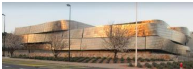
Incinérateur de Calce de 22 MW : 99,6 GWh électriques produits en 2015
