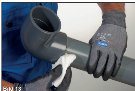
Tryck röret ända in till markeringen av insticksdjupet (Bild 4). Torka bort överflödigt lim.
