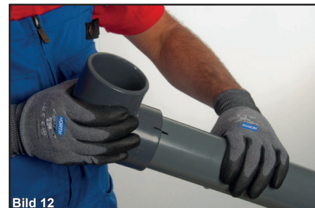
Sätt omedelbart ihop rör med rördelen enligt markering (Bild 7) i en jämn hastighet utan att vrida. Om justering måste göras får det vridas max 45°.
