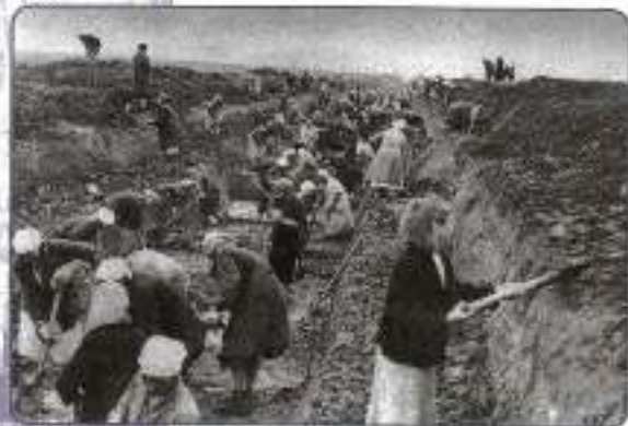
Москвичи на строительстве оборонительных сооружений, 1941 г.
