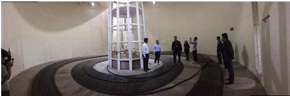
ケーブルを格納するケーブルタンク。
