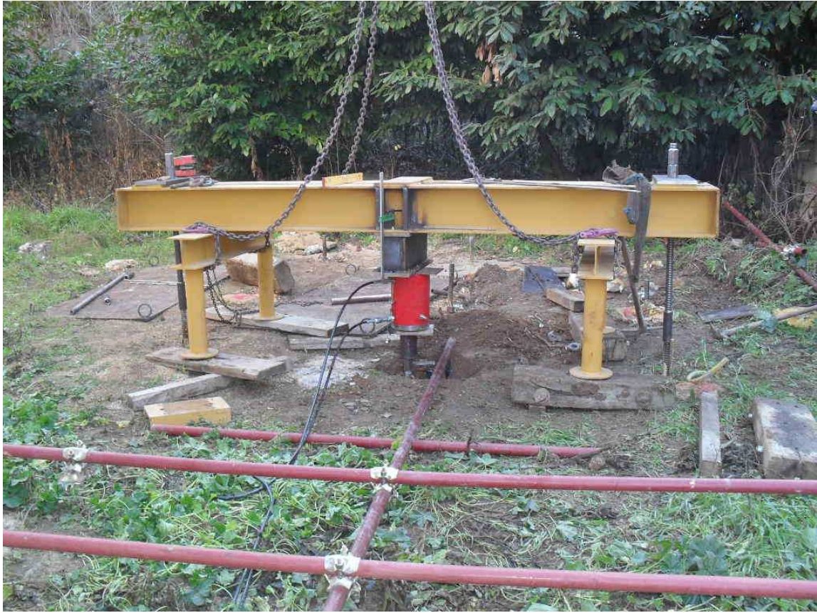
Foto 4 . prova di carico tramite infissione (compressione) Campo 2
