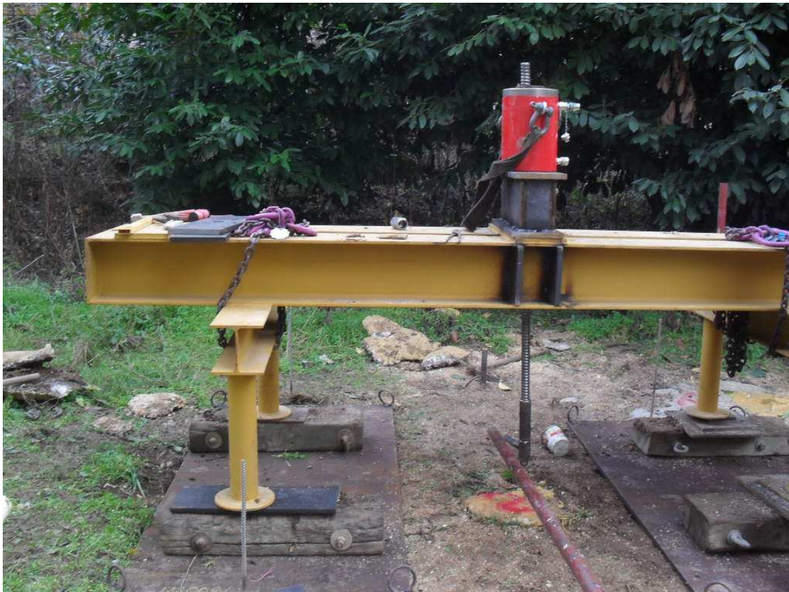
Foto 5 . Prova di carico tramite sfilamento (trazione) Campo 2
