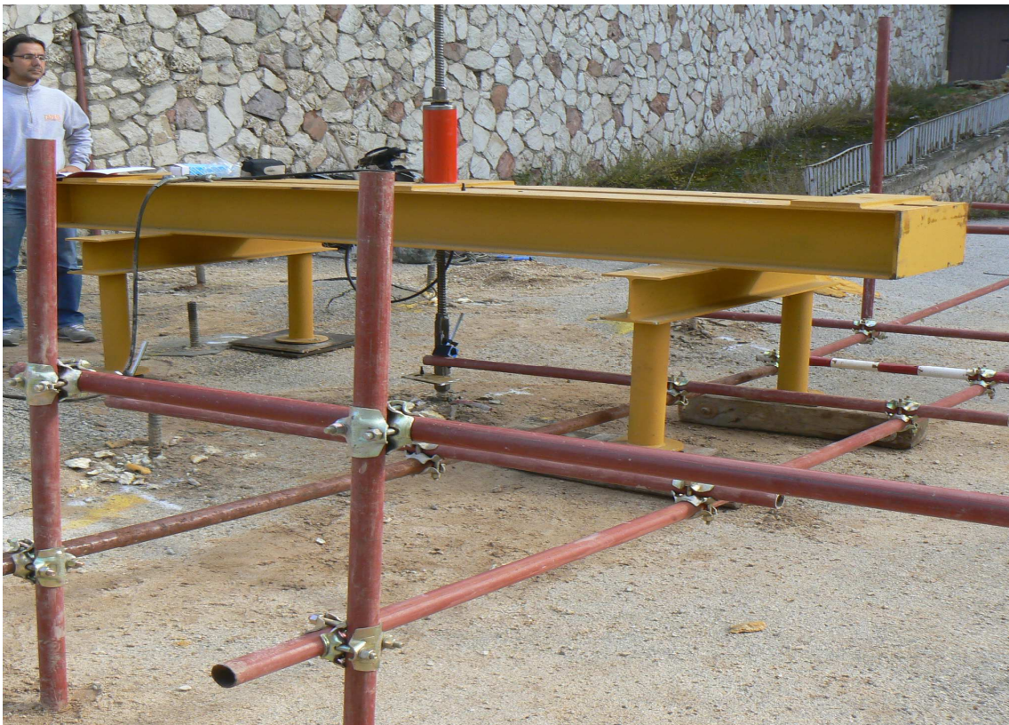
Foto 3 . Prova di carico tramite sfilamento (trazione) Campo 1
