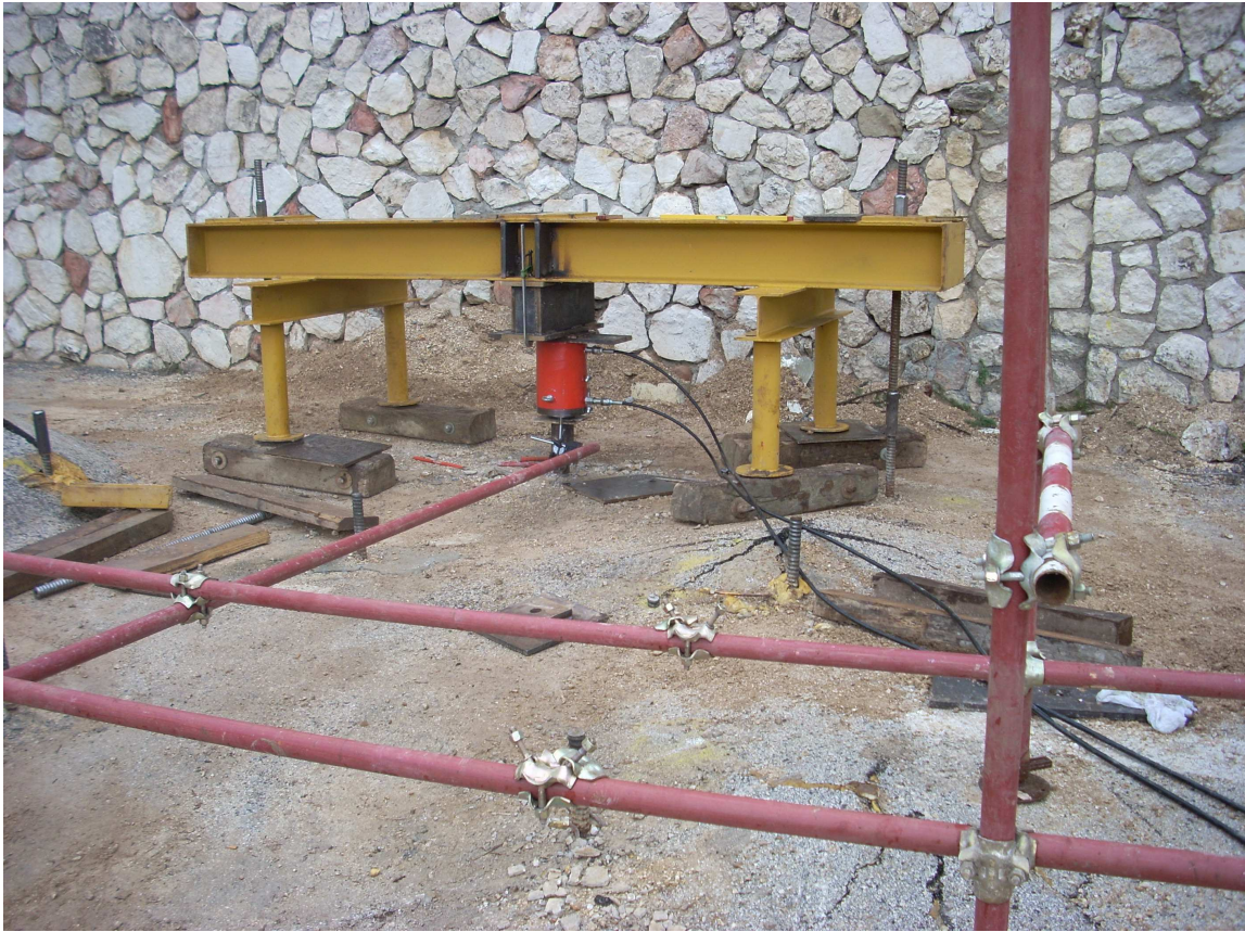
Foto 2 . Prova di carico tramite infissione (compressione) Campo 1
