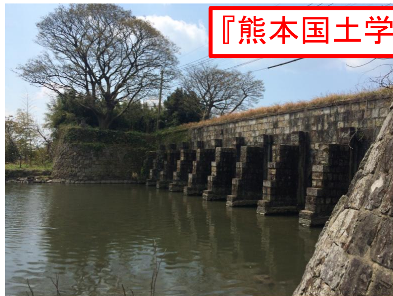
(郡築三番町樋門)
