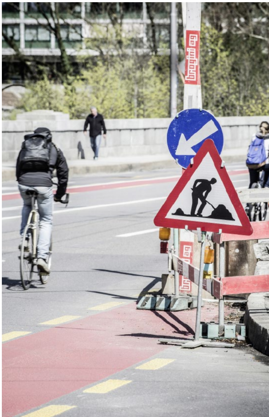
Gefährlich für Velos: Die Baustelle auf der Lorrainebrücke. Foto: Franziska Rothenbühler
