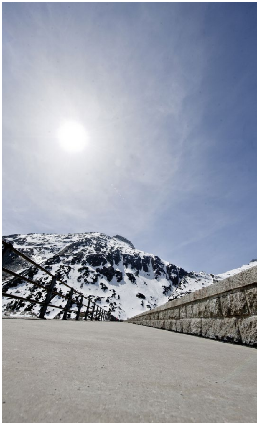
Die KWO will die Grimsel-Staumauer erhöhen. Foto: Adrian Moser
