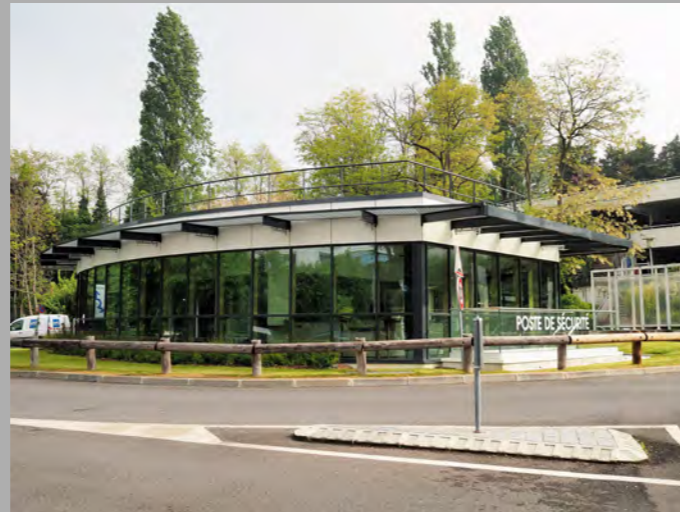
Poste de sécurité rénové et agrandi
