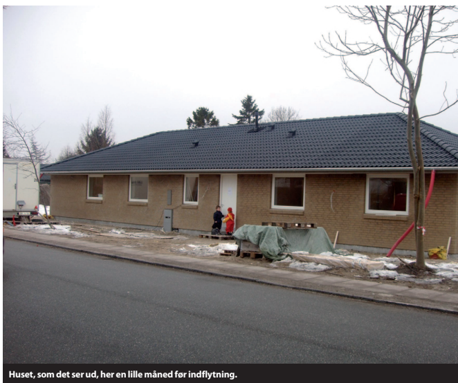
Huset, som det ser ud, her en lille måned før indflytning.
