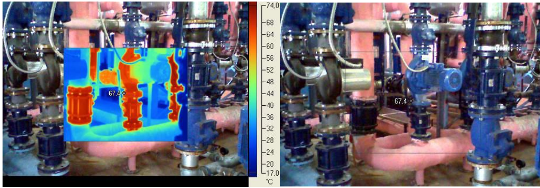
Resim 4.2. Kazan Gidiş ve Dönüş Vanaları
