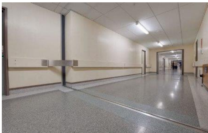
Рис.3: Соединения для предотвращения трещин вследствие теплового движения
