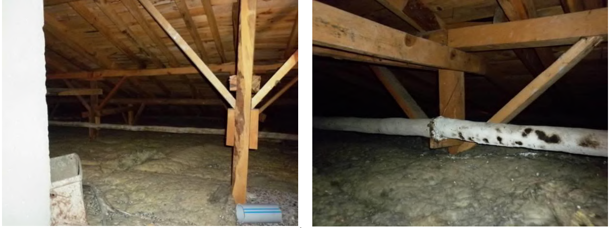
Resim 2.1. İdari Bina Çatı
