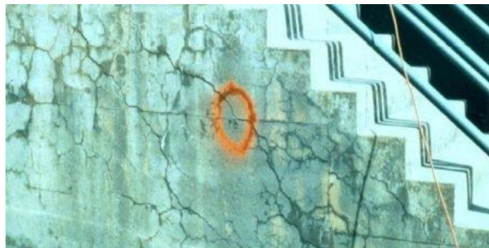
Рис.12: Растрескивание из-за щелочно-кремниевых реакций
