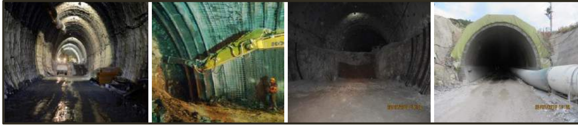
Şekil 5. 3 Honaz Tüneli inşaatına ait görünüm
