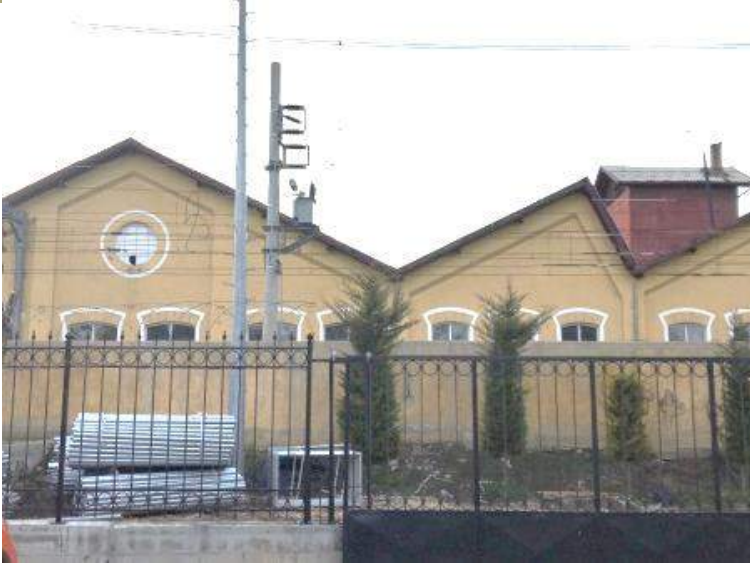
Şekil 15: Konya Tren Garı Onarım Atölyeleri
