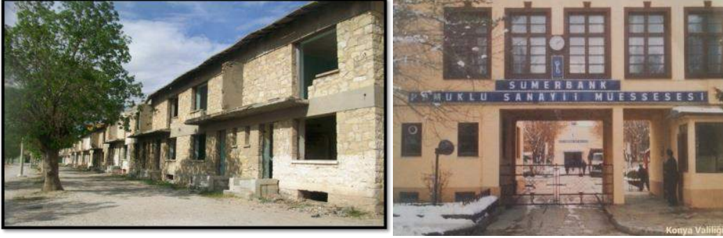
Şekil 17: Ereğli Sümerbank Fabrikası 15
