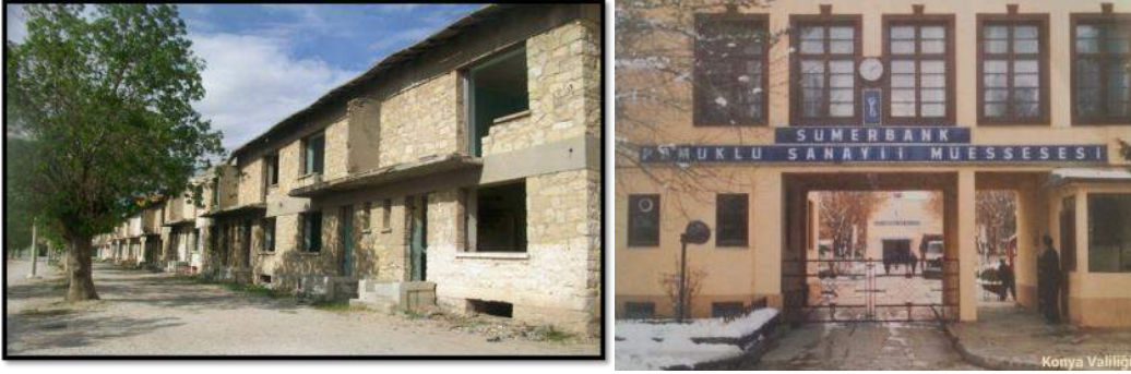
Şekil 17: Ereğli Sümerbank Fabrikası 15
