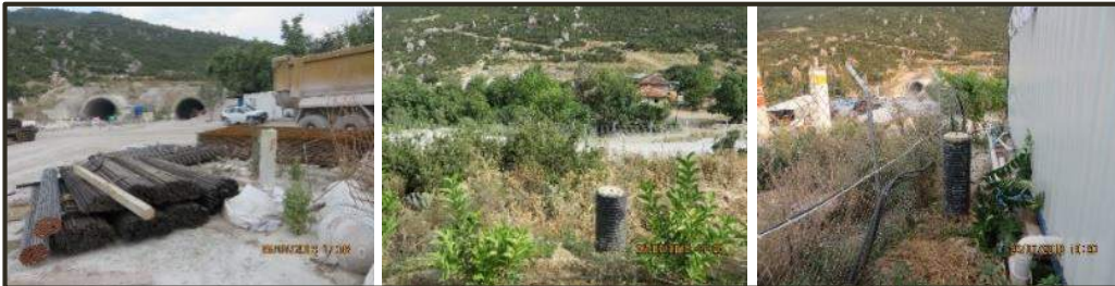
Şekil 5. 5 Honaz Tüneli giriş portalındaki pilyeler
