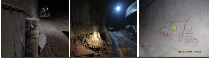
Şekil 5. 10 Honaz Tüneli içindeki pilyeler ve konsol (sağ)
