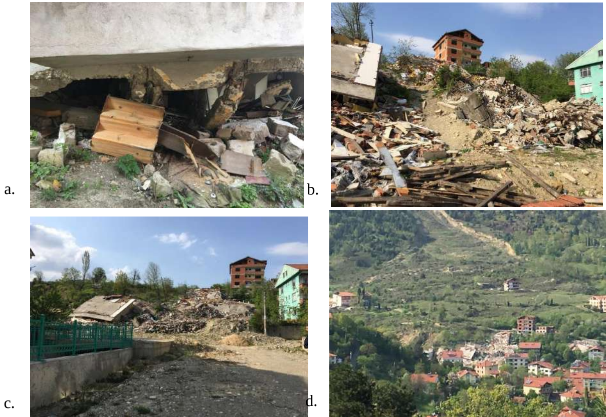
Şekil 4. Heyelanın hasar verdiği yapılar- Karşıyaka mahallesi
