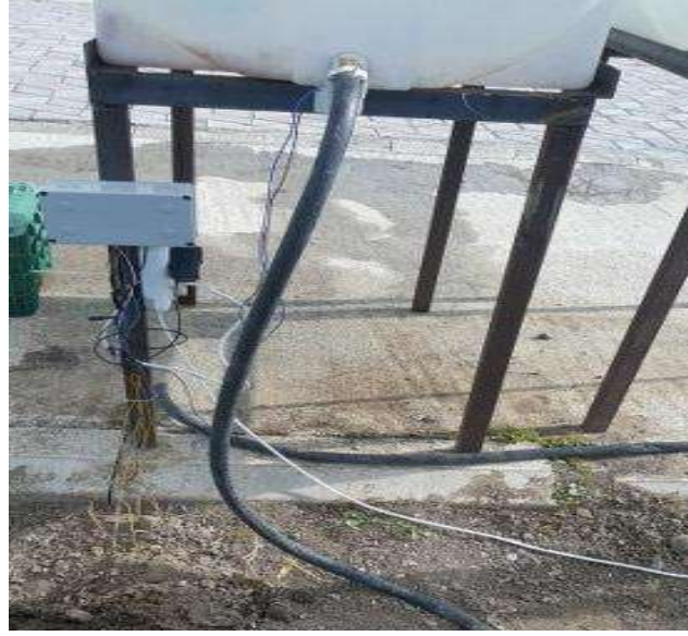
Şekil 2.3. Tasarlanan Sistemin Çalışma Alanına Kurulmuş Durumu
