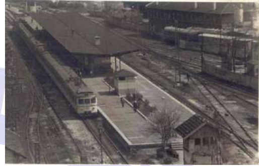
Şekil 24 Yedikule İstasyonu ( http://www.kentvedemiryolu.com )
