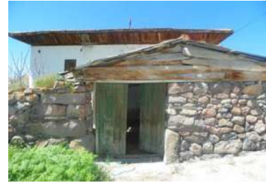
Resim.24 Demirciören Köyü Cami Giriş Kısım
